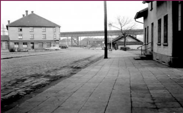
Günnigfelder Str. -1956 -Blick auf die Erzbahntrasse
