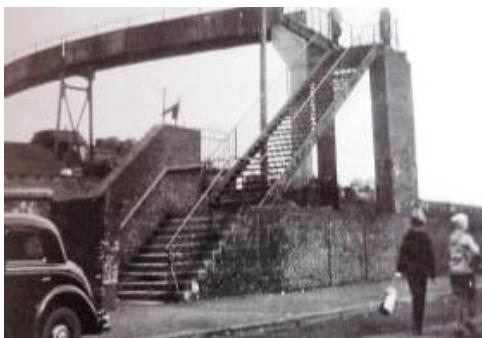
Die Asthmabrücke mit dem südlichen Aufgang um 1930 Foto: Archiv und Sammlung von Thomas Spillmann
