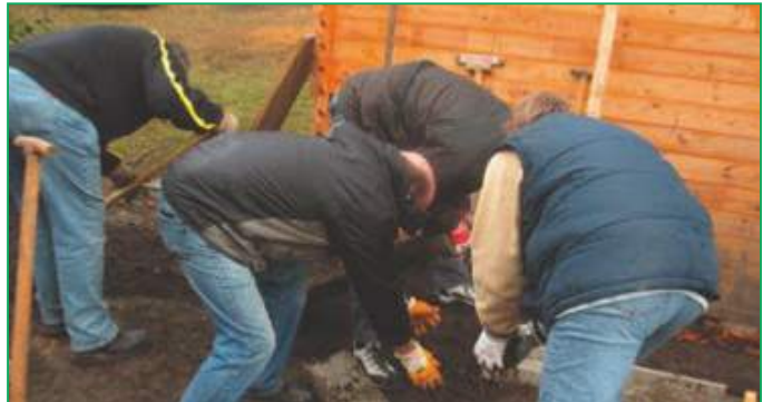
...und halfen unter anderem bei den Vorbereitungen für die neue Bodenplatte der Materialhütte im Kirchgarten.
